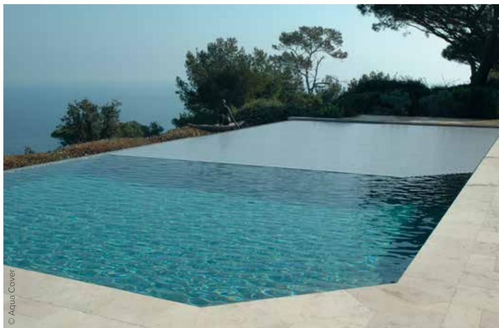
**Cette piscine à débordement sur une longueur, réalisée par Piscine Arrosage Lefebvre, comporte un volet immergé Aqua Cover Easy Confort. Totalement invisible une fois ouvert, il est constitué de lames PVC et possède une motorisation tubulaire, située dans l'axe du volet. En raison du débordement de la piscine, le volet perd sa conformité à la norme de sécurité NF P90-308, mais conserve un intérêt esthétique et pratique en gardant une eau propre et limitant les déperditions de chaleur.**
